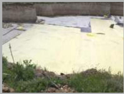
Düzce Yurt İnşaatı
