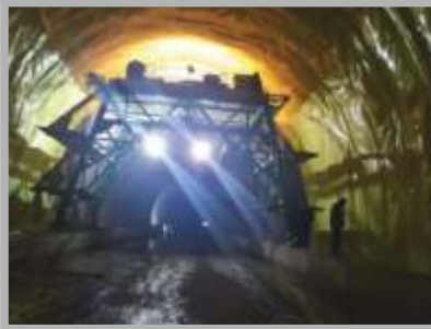
Kığı Yedisu Karayolu Tünel Yalıtımı
