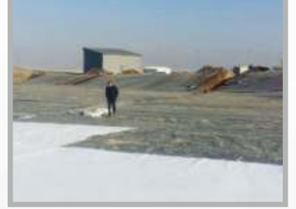
Erzurum Katı Atık Depolama Su Yalıtımı
